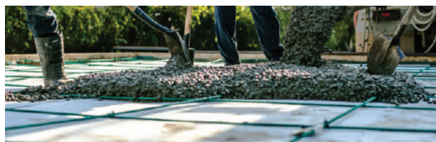
La fabrication de la dalle en béton poreux ou plein
